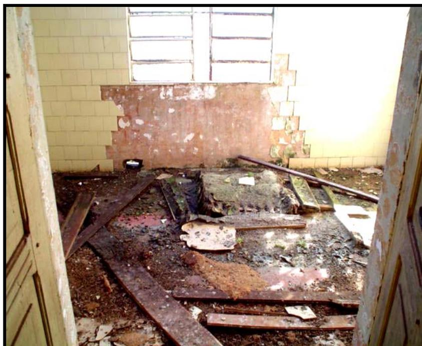
Figura 49 – Umidade agindo sobre revestimentos – Azulejos
