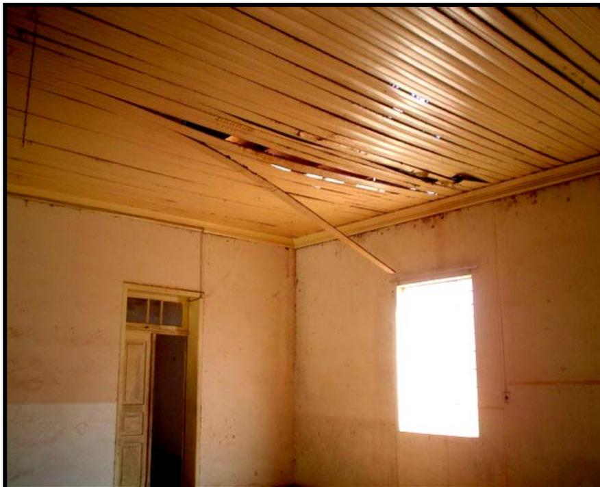
Figuras 44 – Ação das chuvas sobre o forro / Cobertura com parte sem telhas
