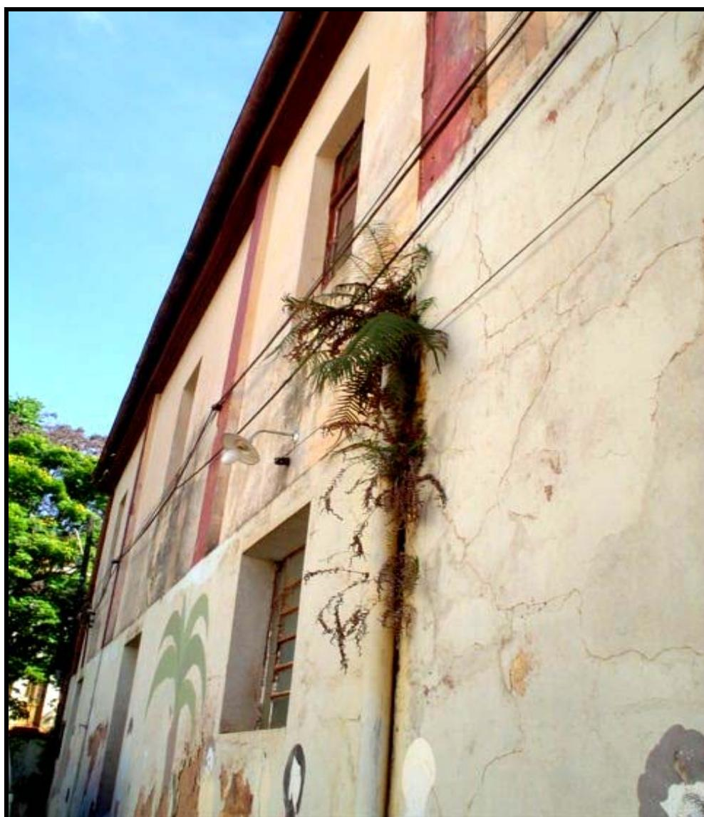
Figura 41 – Reboco deteriorado / Vegetação junto às calhas
