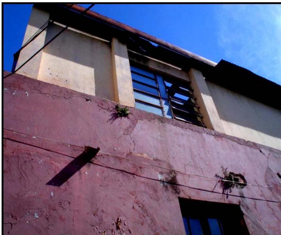
Figura 42 – Calhas e beirais deteriorados
