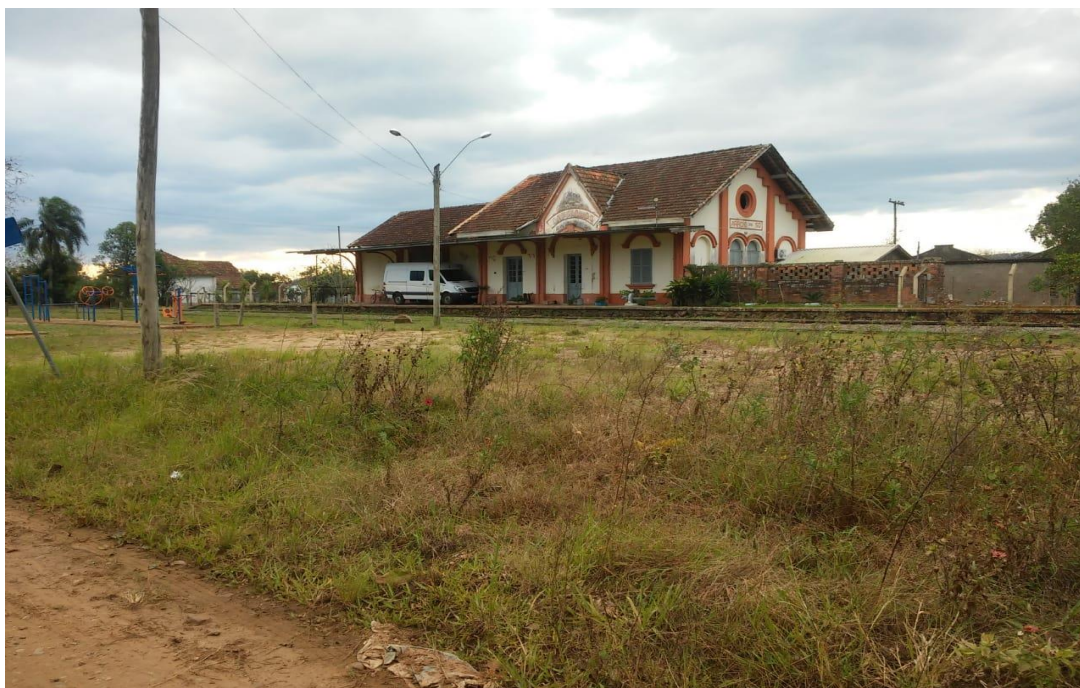
Foto 01 - Estação ferroviária do Arroio do Só
