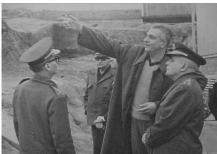
Figura 27 - Pignatari e o Gen. Breno Borges Fortes em visita à construção do Novo Engenho. Foto de 1970
