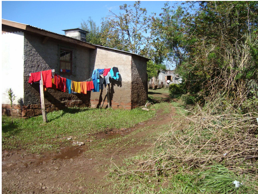
Figura A3 – Casa com a marca da última enchente (janeiro de 2010) do rio Paranhana. Fonte: Secretaria Municipal de Meio Ambiente de Parobé.
