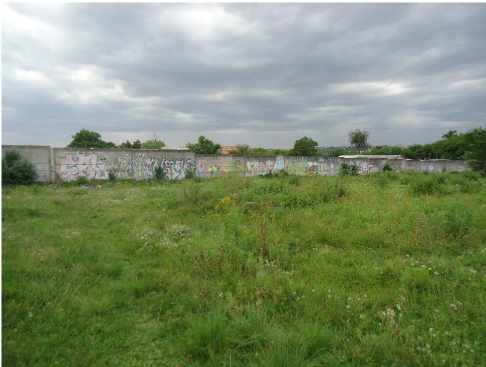
Figura 6: Fotografia do muro, visão do lado nobre. Fonte: capturada pelo próprio autor.
