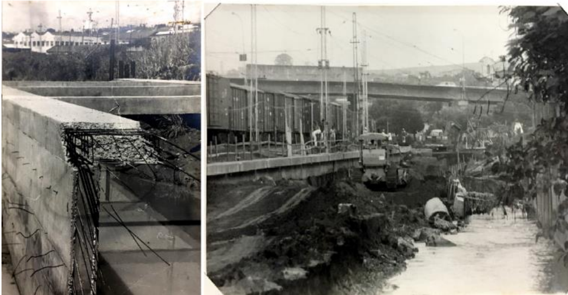
Figura 5 - Fotos das estruturas de sustentação da canalização do Ribeirão Tatu (à esquerda) e suas obras de canalização (à direita). Fonte: C.M.M.H.L, 2019
