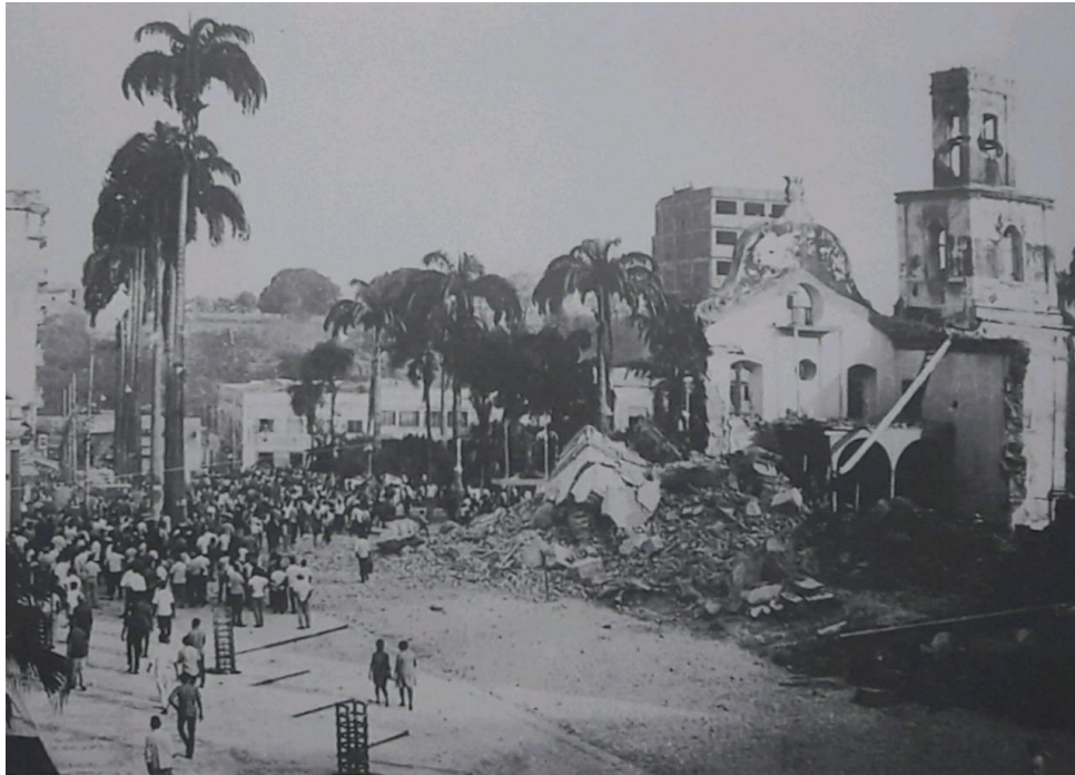
Figura 4 - Demolição da Catedral Barroca para construir a nova Catedral, em 1968. Fonte: FREIRE, 1997.
