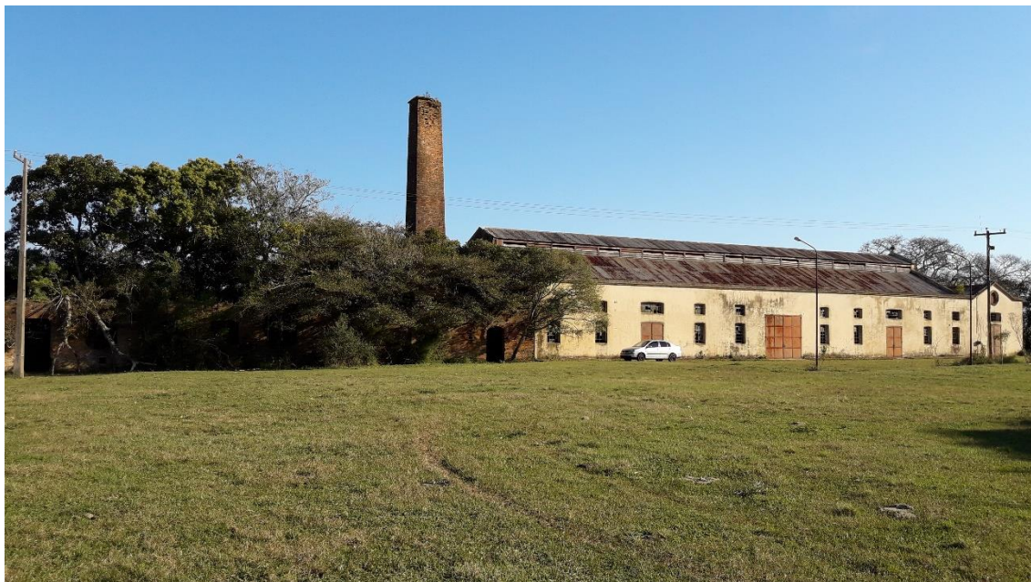
Figura 4 - Edificações restantes da Charqueada Paredão, Cachoeira do Sul - RS. Fonte: fotografia de Leonardo I. G. de Franceschi, 18 de agosto de 2018.
