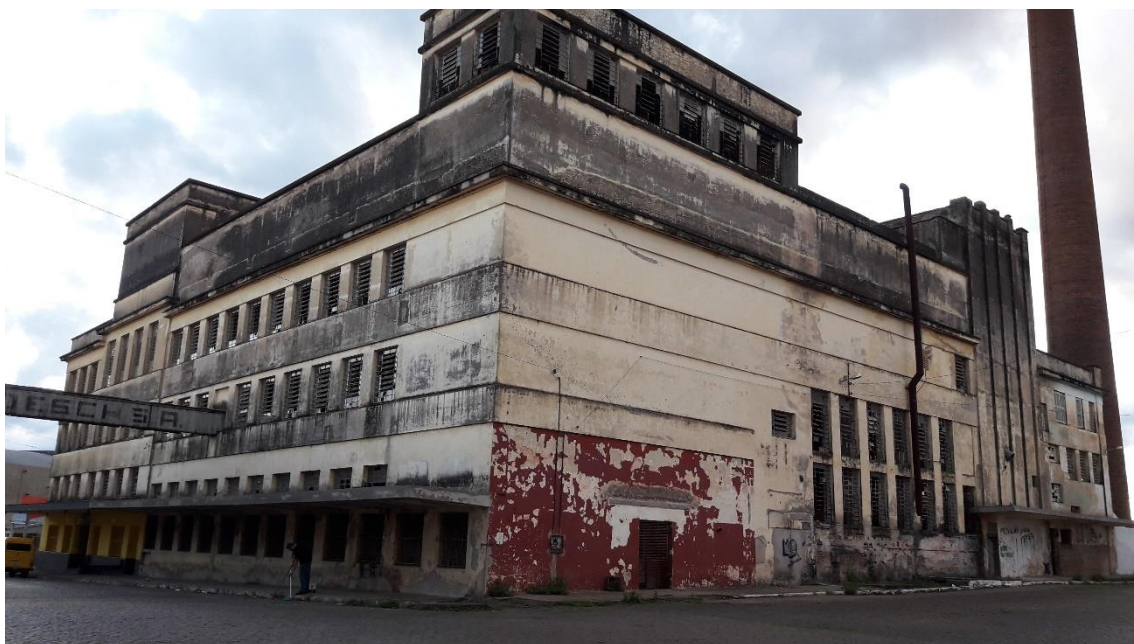
Figura 6 - Edificação parte do complexo do extinto Engenho Brasil, esquina das Ruas Marechal Deodoro e Comendador Fontoura, Cachoeira do Sul - RS.
