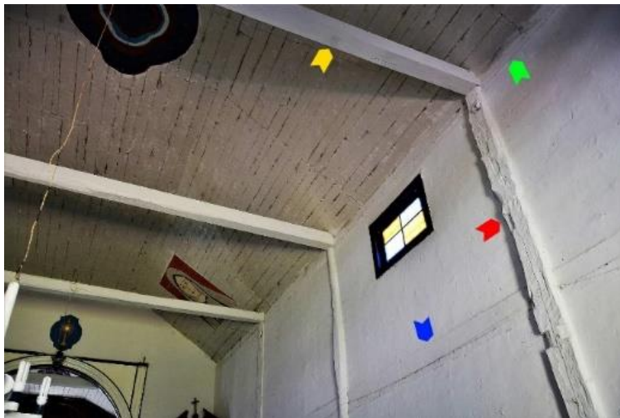
Figura 3 - Segmento do interior da nave da extinta Capela de São Bento, extinto Subdistrito de Bento Rodrigues, Distrito de Santa Rita Durão, Mariana, MG. Fonte: fotografia de Elio Moroni Filho, 2015.
