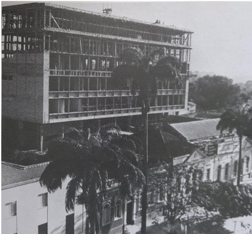
Figura 5 - Construção do novo Palácio do Governo, nos fundos da Delegacia Fiscal, Palácio Alencastro e da independência Municipal. Década de 1960. Fonte: SIQUEIRA et al. (2006)
