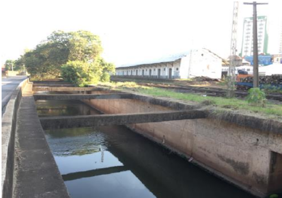
Figura 6 - Foto da situação atual do trecho do Ribeirão Tatu, atrás da Antiga Estação Ferroviária. Fonte: Autoria Própria (2019).
