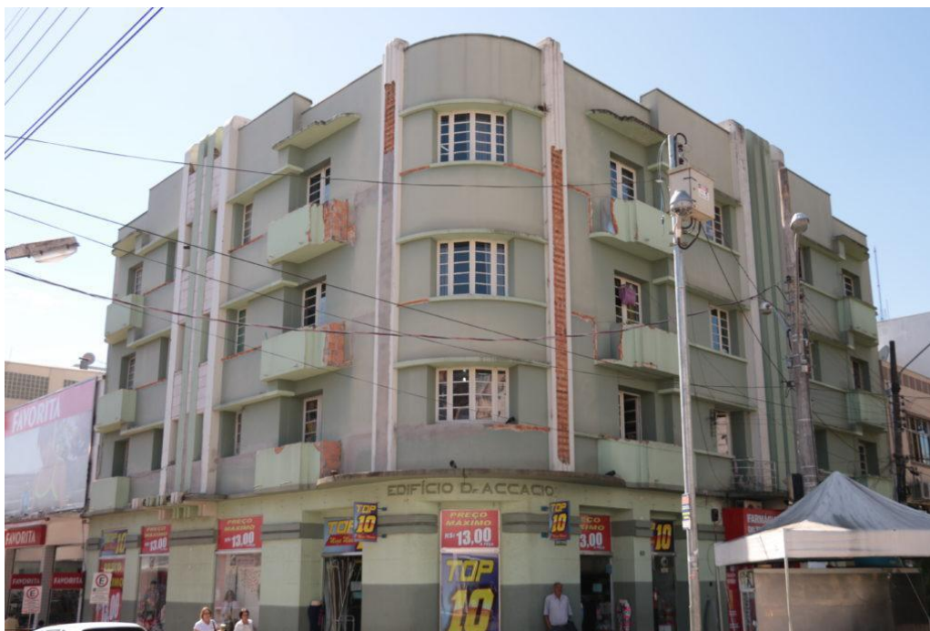
Figura 7 - Edifício Dr. Accacio no início das obras de reforma. Fonte: fotografia de Camila Paes/Jornal Correio Lageano, 2017.
