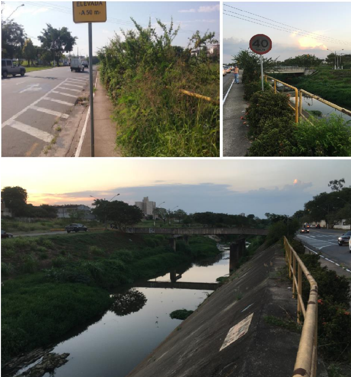
Figura 8 - Fotos da situação da área livre do fundo de vale em 2018 (à esquerda) e da situação atual deste trecho conhecido como "Ponte Preta" (à direita e abaixo). Fonte: Câmara Municipal (2018) e Fotos de autoria própria (2019).
