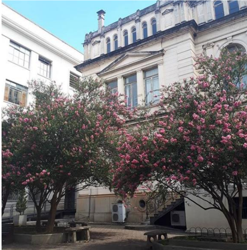
Figura 3 - Foto da edificação Hipólito Pujol. Fonte: do autor, 21 de dezembro de 2018.
