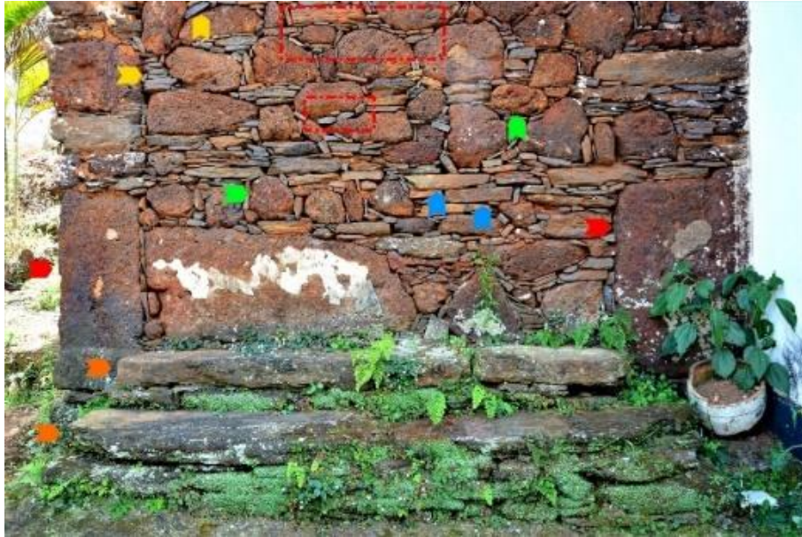
Figura 1 - Trecho de parede da capela-mor, Capela de Nossa Senhora da Conceição, Distrito de Passagem, Mariana, MG. Fonte: fotografia de Elio Moroni Filho, 2016.
