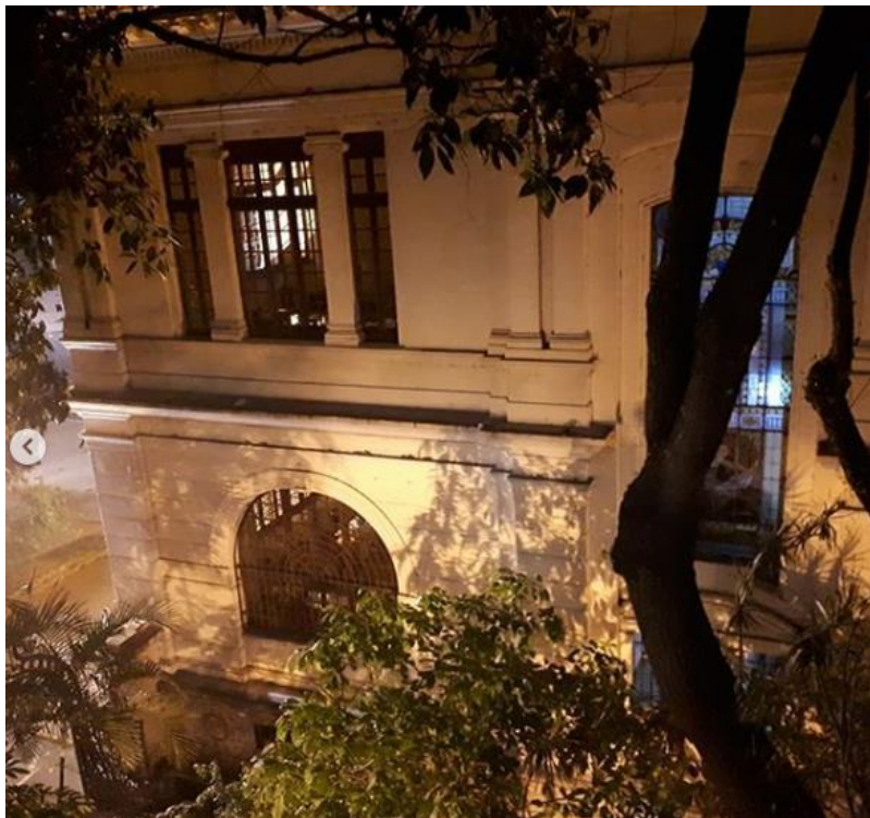
Figura 4 - Foto tirada de dentro da edificação Hipólito Pujol com vista para o Arquivo Municipal. Fonte: do autor, 25 de setembro de 2018.
