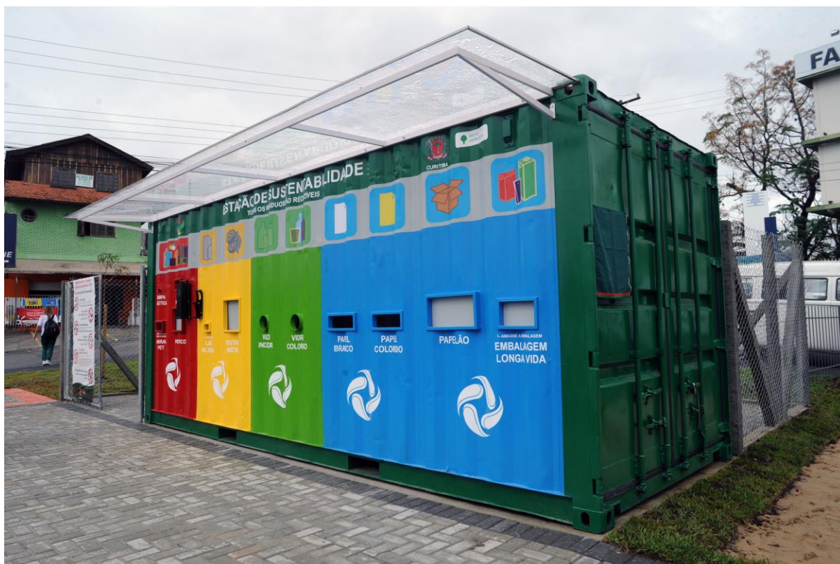
Figura 10 – Estação de Sustentabilidade de Curitiba Foto: Everson Bressan / Secretaria Municipal de Comunicação Social
