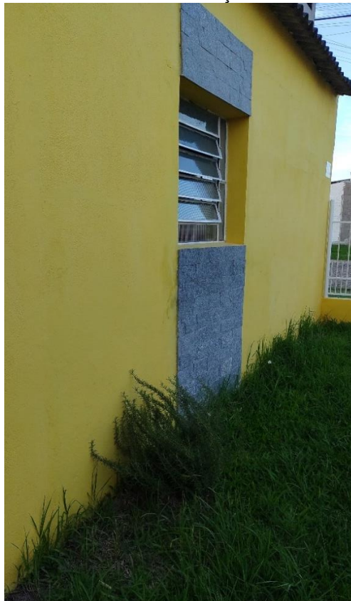
Figura 12 – A casa da tia Conceição em Dom Pedrito.
