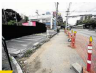
PRÓXIMA ETAPA DA TRINCHEIRA DA CRISTÓVÃO COLOMBO É A ESCAVACÃO
