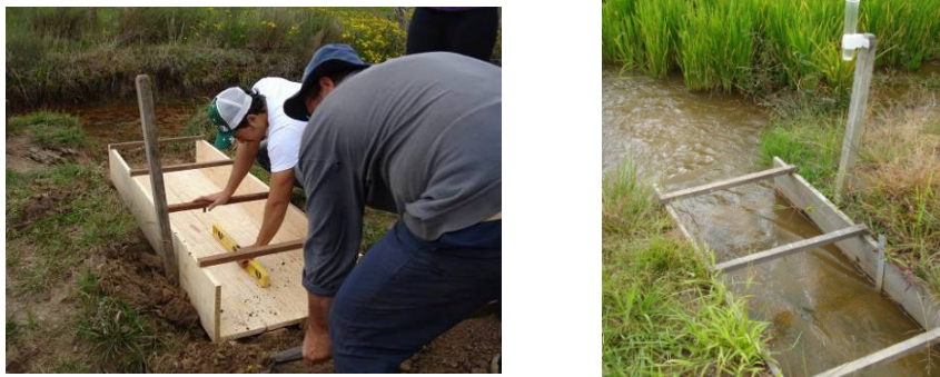
Figura 3.6 – Implantação, nivelamento e águação da estrutura sobre o canal em terra. Santa Maria, RS, 2010.
