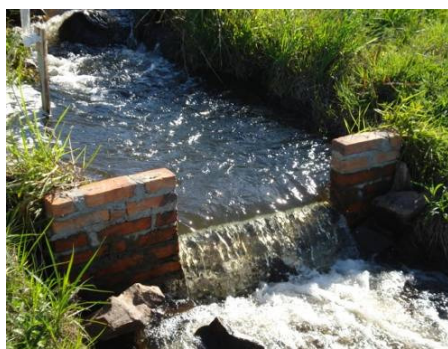
Figura 3.3 – Vertedor Retangular com soleira delgada em alvenaria. Santa Maria, RS, 2010.
