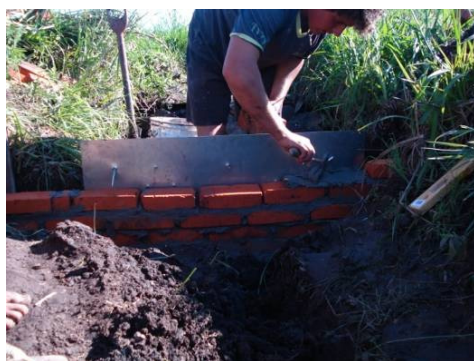
Figura 3.3 – Vertedor Retangular com soleira delgada em alvenaria. Santa Maria, RS, 2010.
