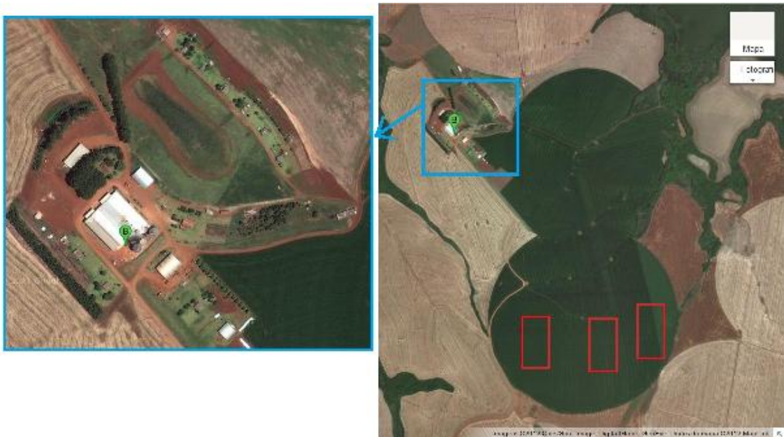
Figura 1 – Vista da área experimental, gerada pelo software Google Earth.
