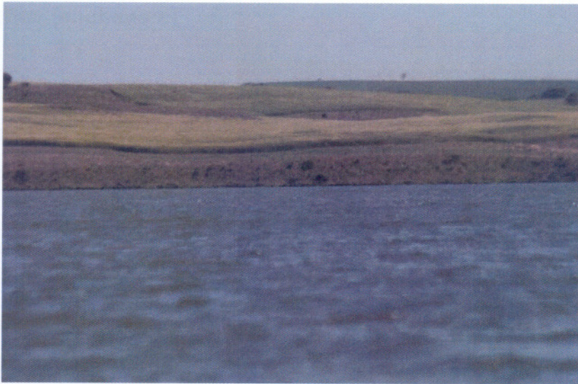
Figura 23 - Observa-se as margens da barragem Val de Serra sem APP.
