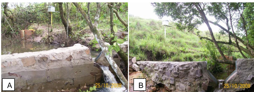
Figura 5.9 - Estrutura hidráulica com poço tranqüilizador da microbacia de campo (A) e da microbacia florestada (B), sob as coordenadas 702968 E, 6643251 S e 704445 E, 6630250 S, respectivamente.
