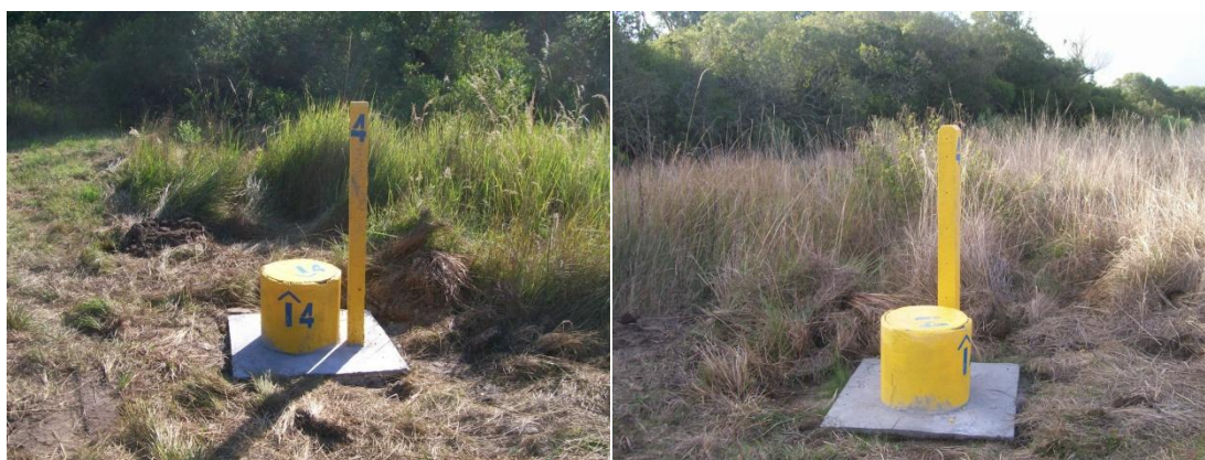
Figura 5.16 - Poço de monitoramento nº 4 localizado próximo ao córrego dentro da APP.
