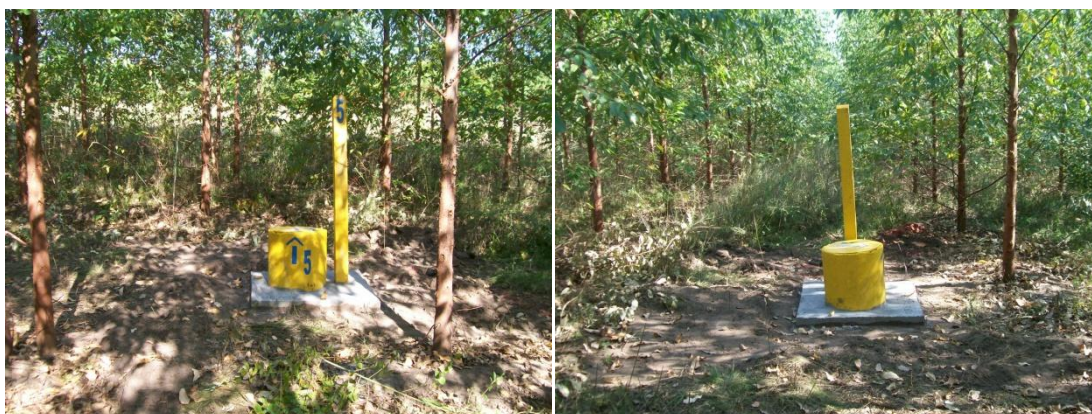
Figura 5.17 - Poço de monitoramento nº 5 localizado à 60 m do poço nº 4.
