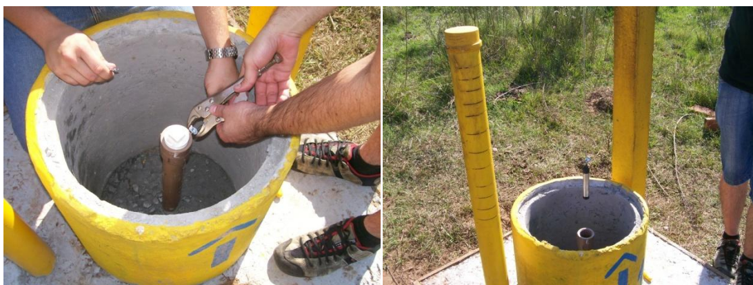
Figura 5.19 - Instalação de sensor no poço de monitoramento.
