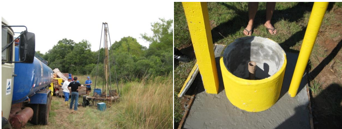
Figura 5.12 - Perfuração e construção da estrutura protetora dos piezômetros.
