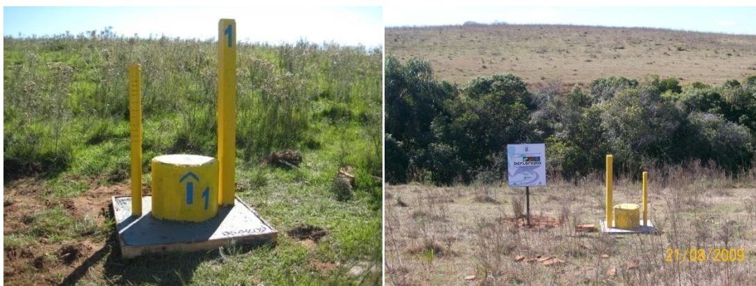
Figura 5.13 - Poço de monitoramento nº 1 na MC.
