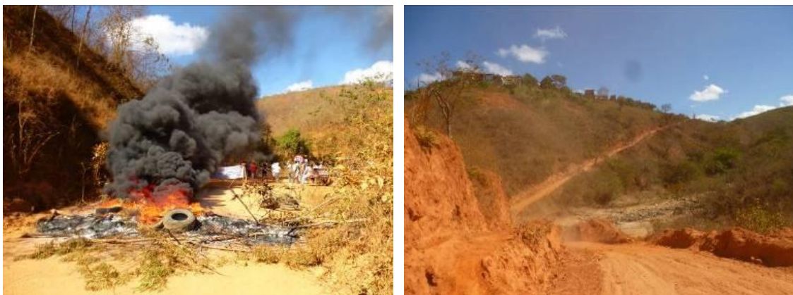
Figura 10 – Imagens ilustrativas da Estrada que liga o município de Minas Novas no Alto Jequitinhonha ao município de Araçuaí no Médio Jequitinhonha, trecho sem asfalto.
