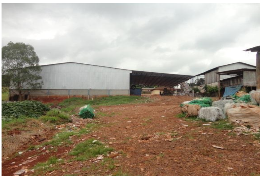
Figura 26 – Estrutura de pavilhões de alvenaria da Copercicla
