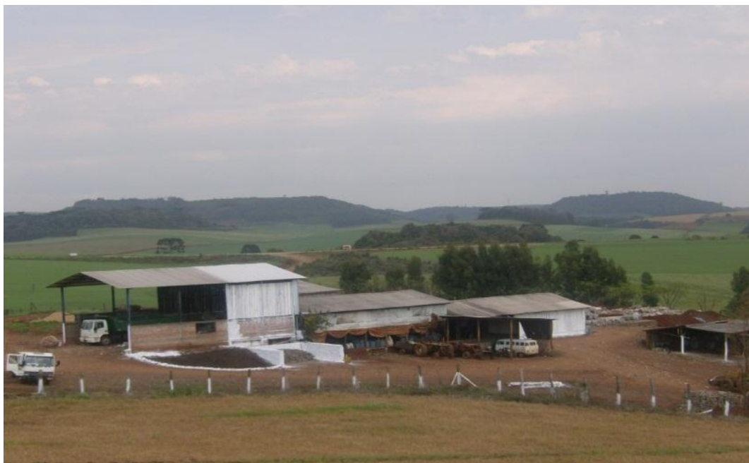
Figura 15 – Estrutura inicial das instalações da Copercicla (2)
