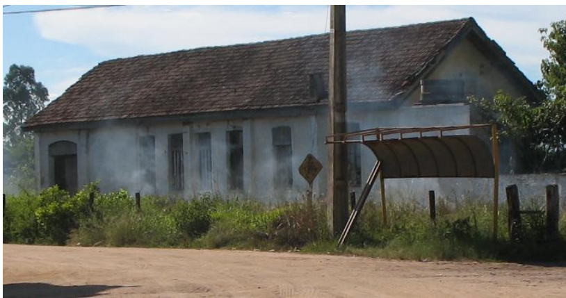
Fotografia 41 : Estação Ferre de Jacuí Fonte: Cirolini, 2006. Org.: Pozzer, G.
