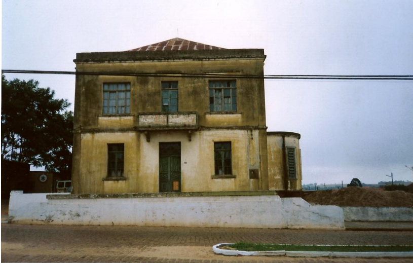
Fotografia 39: Prédio Miguel De Patta Fonte: Trabalho de Campo Org.: Pozzer, G.
