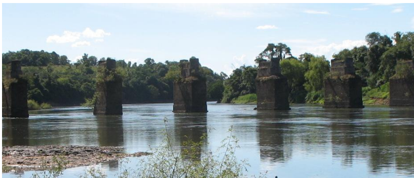
Fotografia 32: Ponte do Império sobre o Rio Jacuí. Nas margens o predomínio de matas-galeria. Fonte: Cirolini, 2006. Org.: Pozzer, G.
