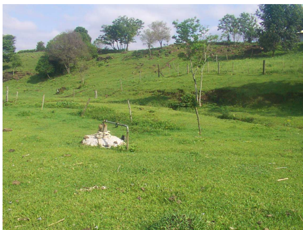
Figura 16 - Ilustração do poço tubular Surgente nº 6 da linha Natal (NL – 6), falta de cercamento
