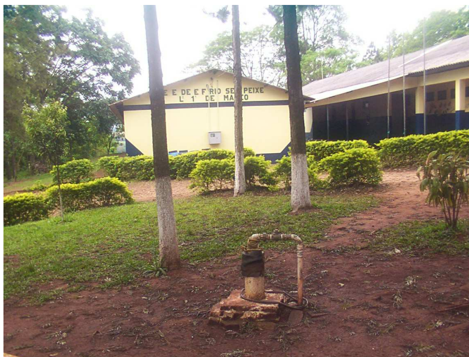
Organizado por: PASSOS, V. F. dos, 2007 Poço tubular nº. 1 de Oito de Maio (OM – 01), ausência de laje em concreto e cercamento.
