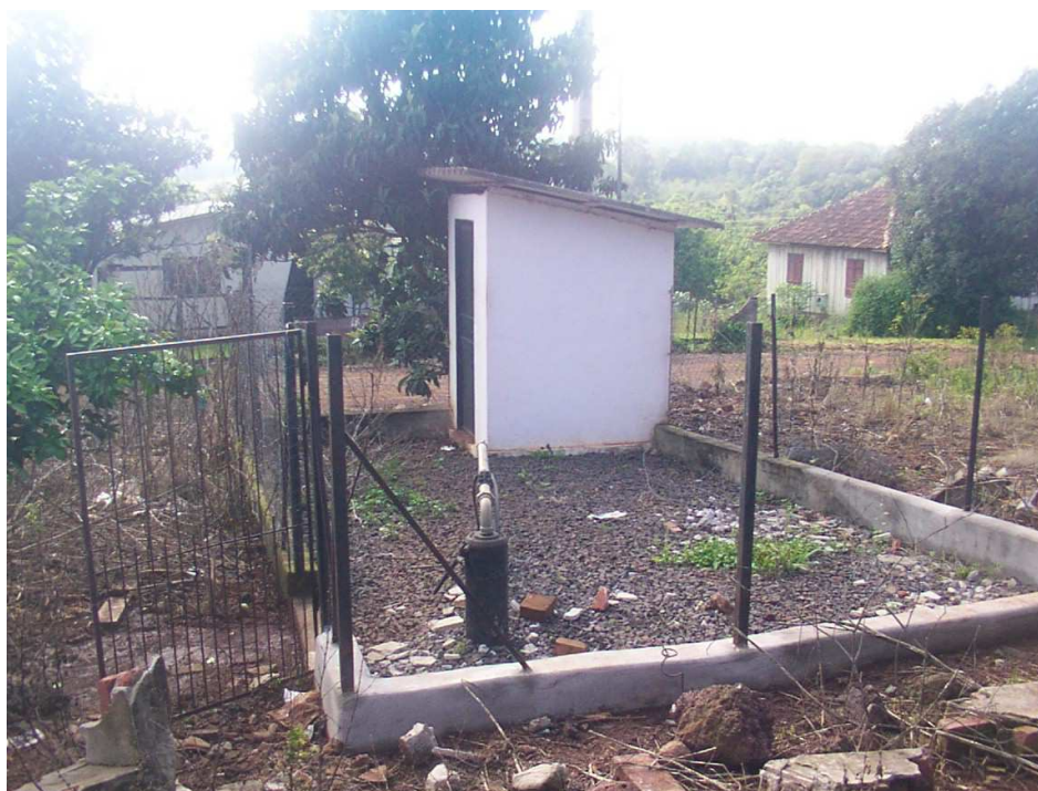
Organizado por: PASSOS, V. F. dos, 2007 Poço tubular nº. 32 da Linha Ressaca (R – 32, ausência de laje em concreto.
