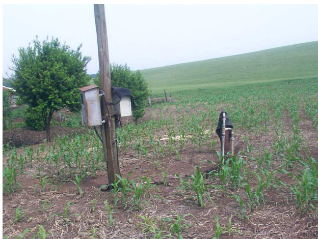
Figura 10 - Poço tubular nº 36 da linha Pio X (BIS/PX – 36), falta de cercamento e laje de concreto
