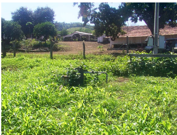
Figura 09 - Poço tubular nº 11 da Linha Buriti (BI -11), falta de cercamento e laje de concreto, localiza-se numa lavoura de milho
