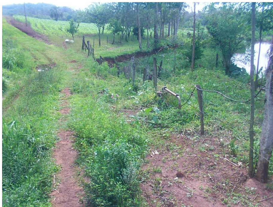
Organizado por: PASSOS, V. F. dos, 2007 Poço tubular nº. 27 da Linha Paca Sul (PS – 27), ausência de laje em concreto.
