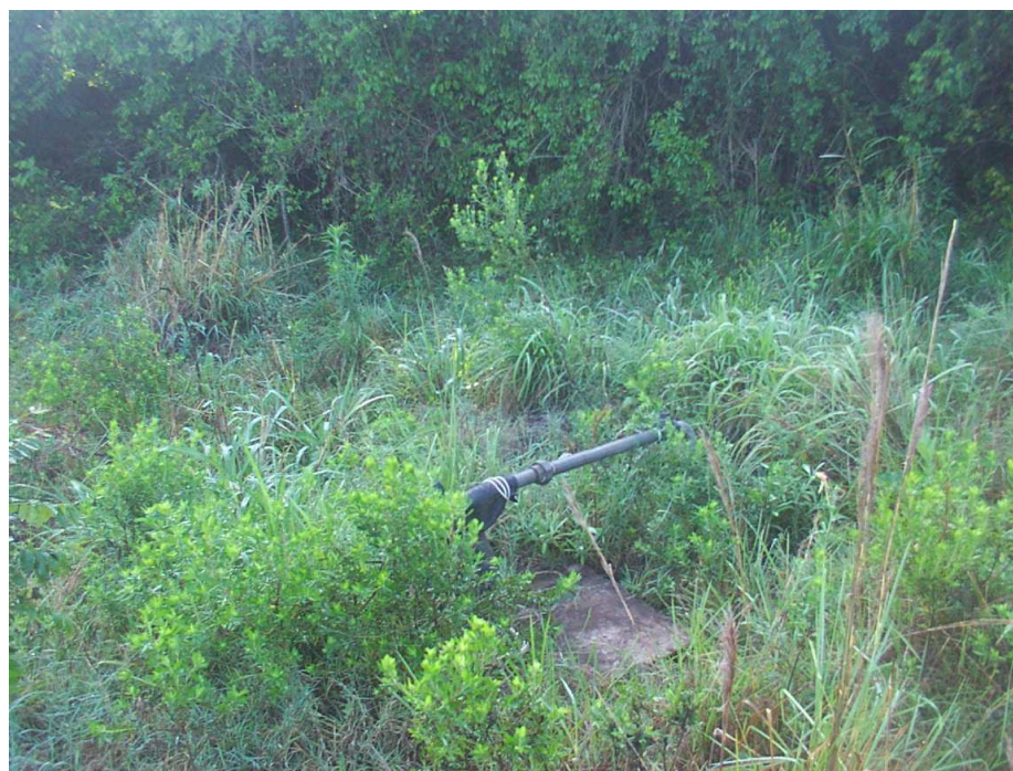
Organizado por: PASSOS, V. F. dos, 2007 Poço tubular nº. 30 da Linha Doze (D – 30), ausência de laje de cercamento.
