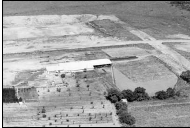
Figura 11 – Início das obras para a instalação da UFSM – 1960.
