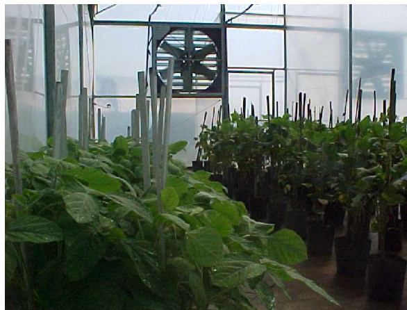
Foto 1. Sistema de refrigeração presente na casa de vegetação.
