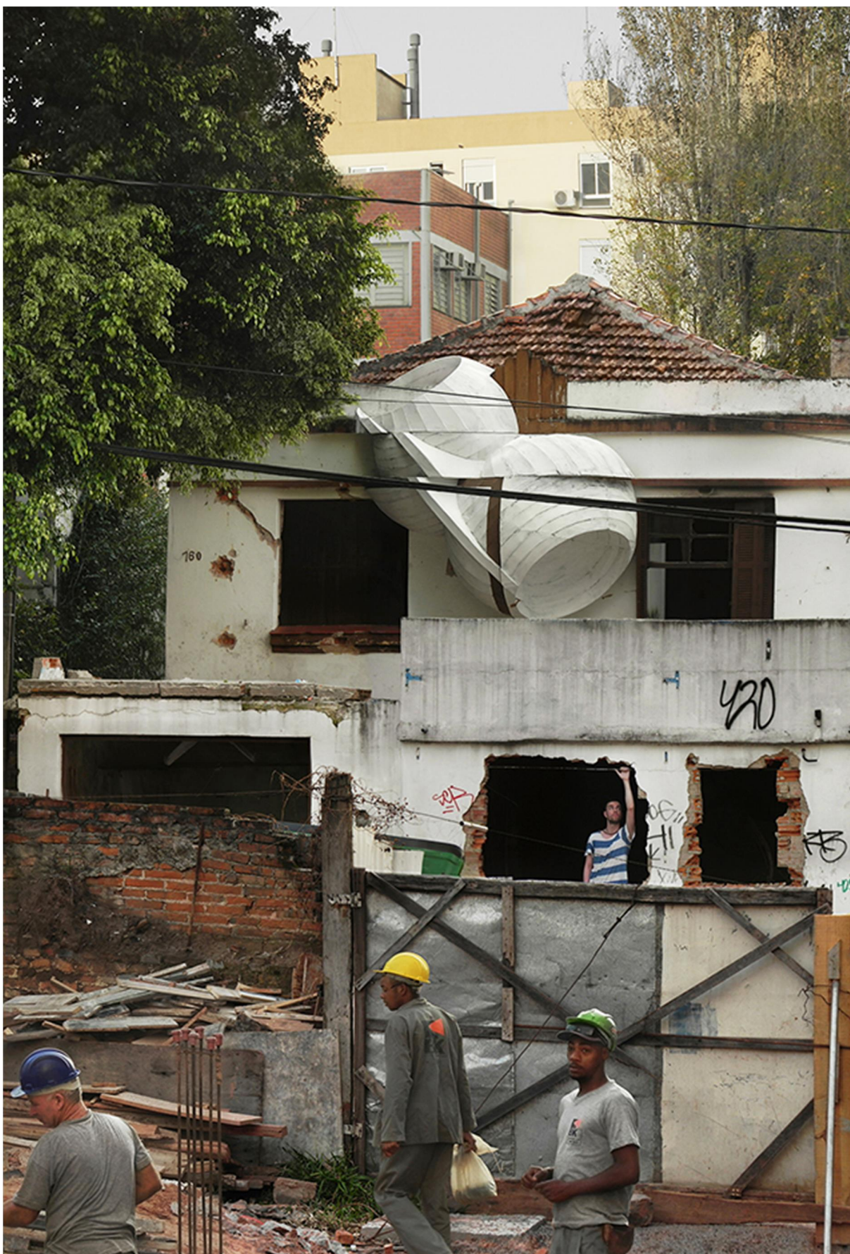
Figura 69 - #4. Rua Duque de Caxias, Santa Maria. Papelção e tinta sobre casa em demolição. Abril de 2013.
