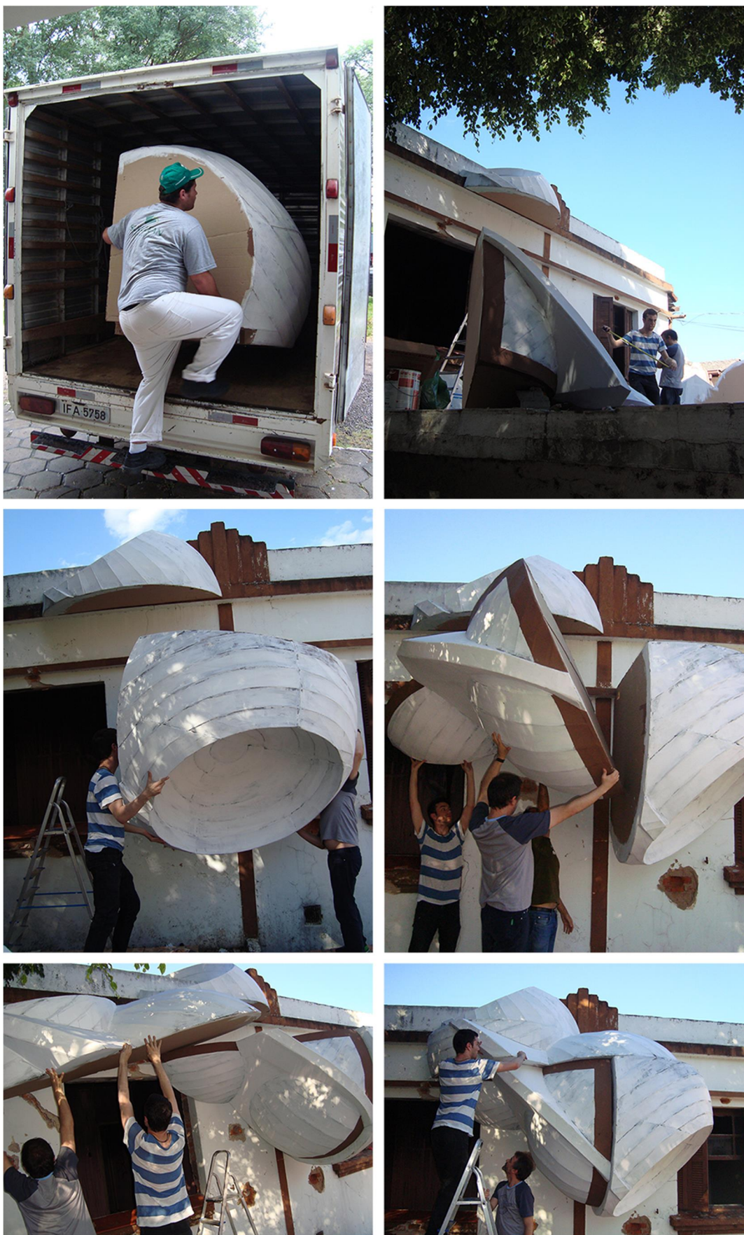
Figura 71 - Instalação de #4 em local-destino.
