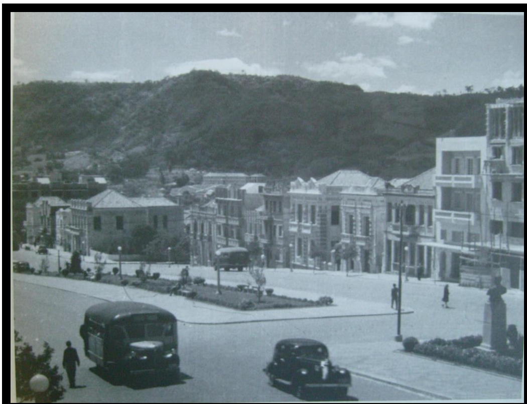
Anexo AD - Vista parcial da Avenida Rio Branco, trecho entre as Ruas Silva Jardim e Vale Machado, década de 1940 (MORALES, 2008, p. 131)
