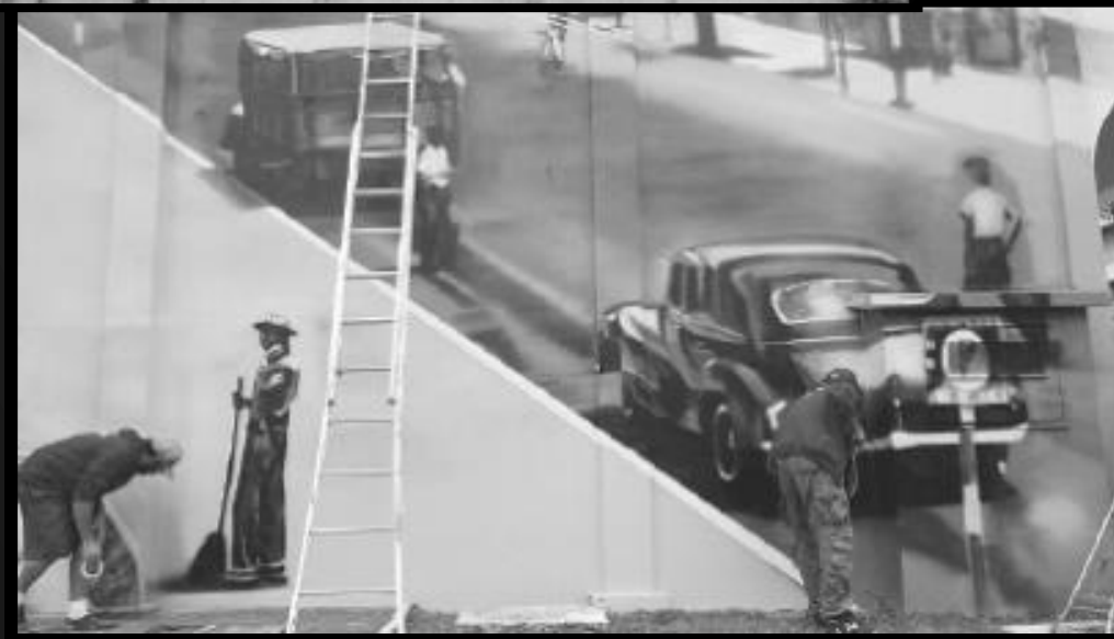
Fig 43; 44. Obra nos fundos da Biblioteca Municipal de Santa Maria 62
