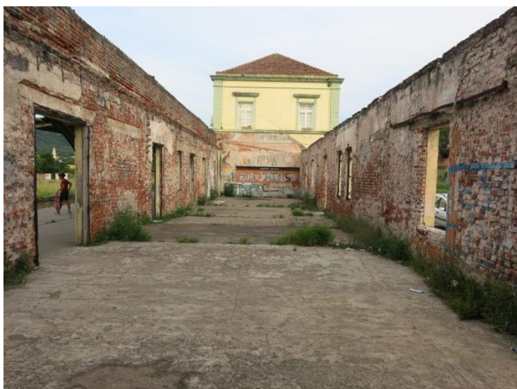
Figura 01 - Arquitetura com vista para sede da Secretaria da Cultura de Santa Maria
