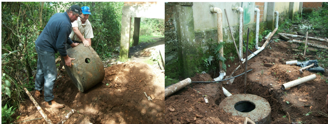
Figura 9 - Preparo para colocação da fossa séptica – Sociedade Farroupilha Linha Boêmia/Agudo – setembro/2010
