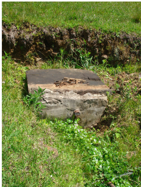
Figura 13 - Construção de fonte protegida/drenada – Empreendimento Cascata Raddatz – Linha Teotônia/Agudo – outubro/2010
