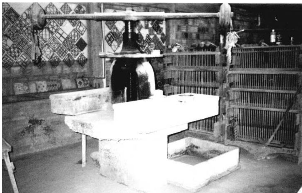
Figura 16 – Prensa hidráulica manual – fábrica Bevillaqua & Luchese.
