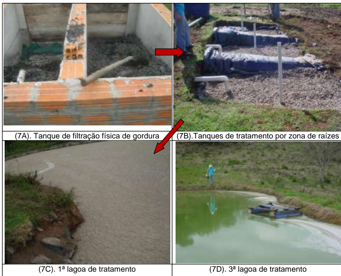
Figura 7 - Tanques construídos para estudo (7A e 7B), e das lagoas usadas pelo proprietário atualmente (7C e 7D) na agroindústria Parlacto produtora de queijo.
