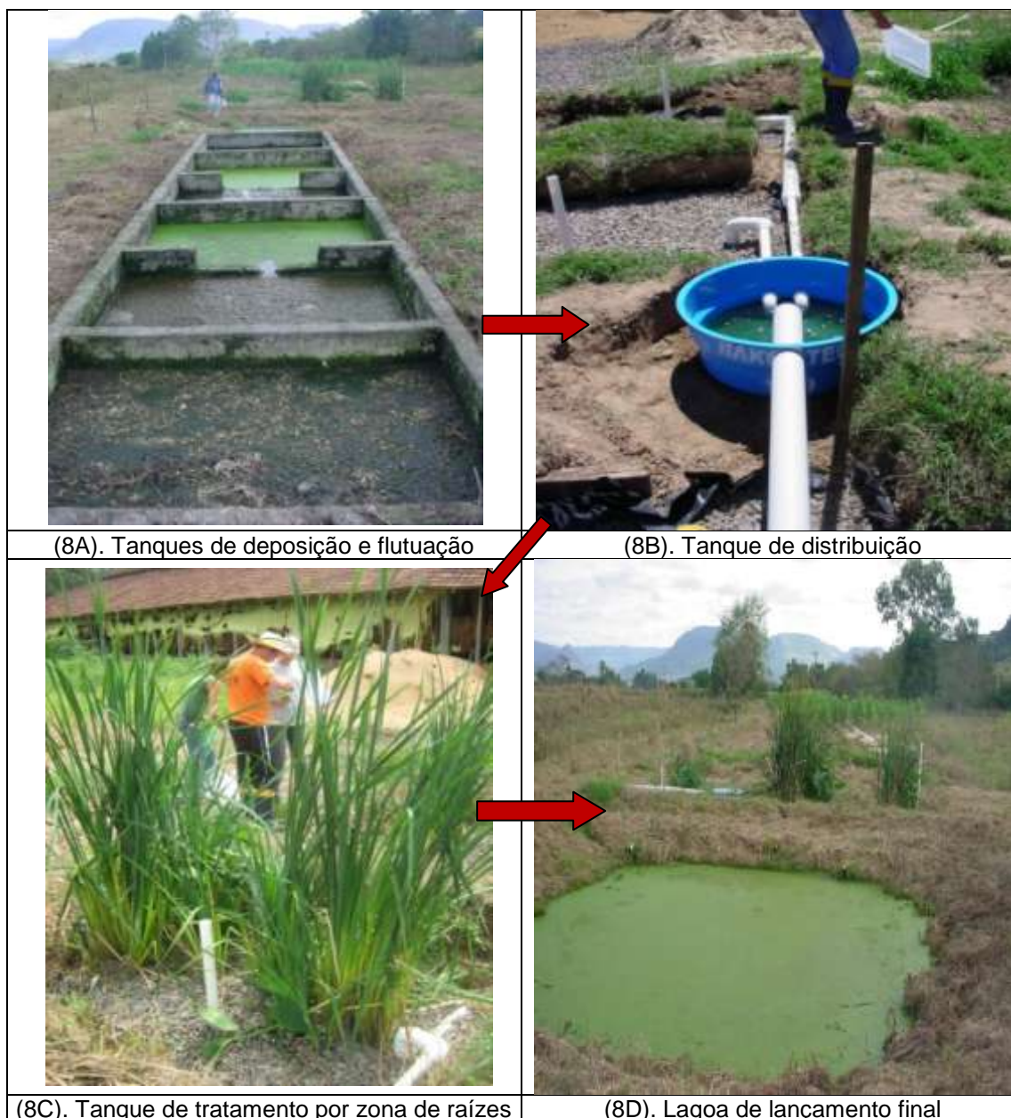
Figura 8 - Tratamento de resíduo líquido na agroindústria Abatedouro de Aves.
