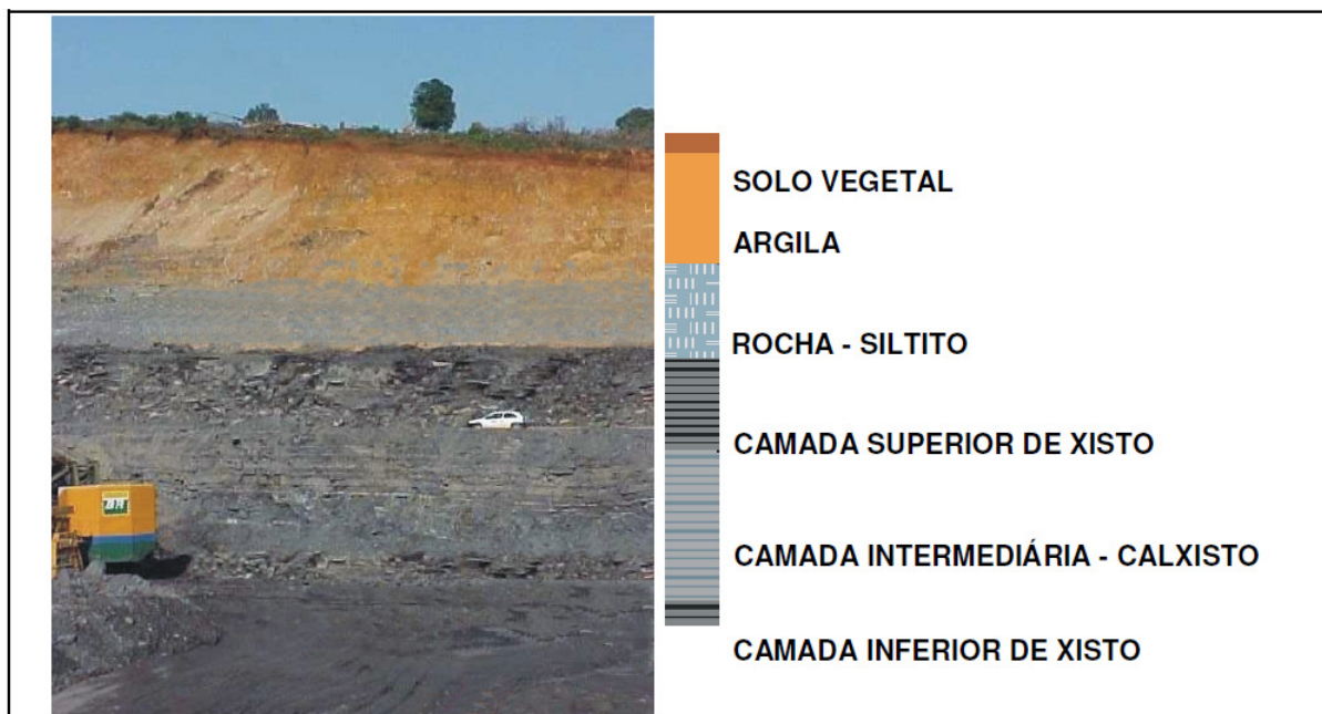
Figura 3.2 – Perfil do terreno natural mostrando as diferentes camadas da coluna estratigráfica (Adaptado de Baggio, 2007).
