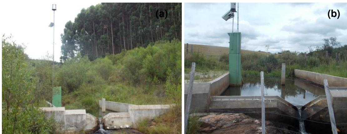
Figura 26 - Seção de monitoramento da precipitação e da vazão na bacia com eucalipto (a) e na bacia com campo nativo e pastagem manejada (b), São Gabriel-RS.
