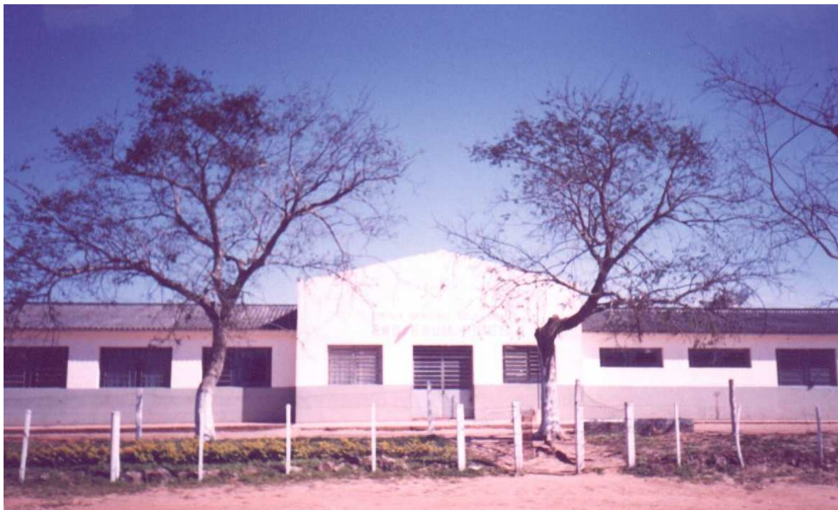
Figura 2: Foto da Fachada da Escola Eno Brum Pires – Vista Frontal.
