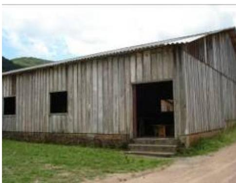
seja de madeira, com longas e largas tábuas na posição vertical, no interior, o chão é revestido com piso e a cancha de bochas, com material sintético. Apenas a cozinha permanece o chão de terra batida.
