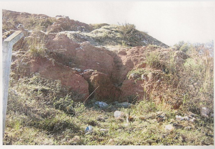
Problemas Ambientais Gerados pelo Lixão: Acima chorume escorrendo por valetas (foto 2) e abaixo as erosões causadas no solo pelo lixo (foto 3)
