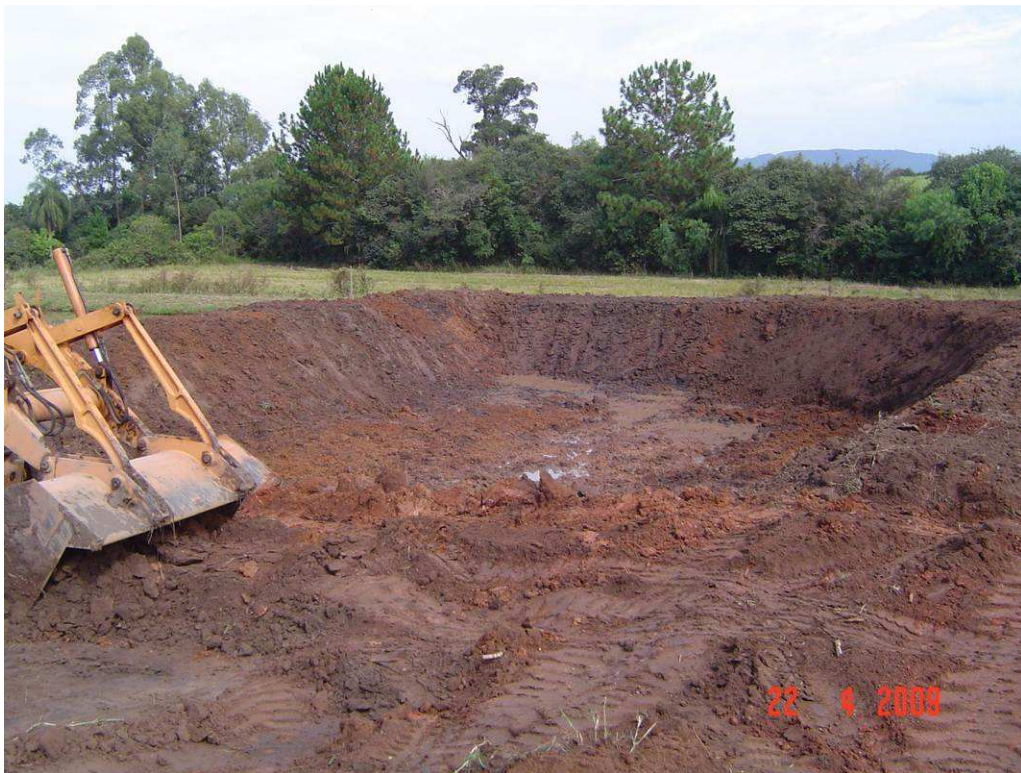
Figura 2.5 - Tanque em fase de construção em propriedade inserida no APL da Piscicultura do COREDE Jacuí-Centro (crédito: Edson Blini)
