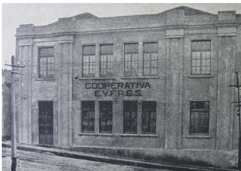
Imagem 09: Prédio central da COOPFER – Santa Maria RS
