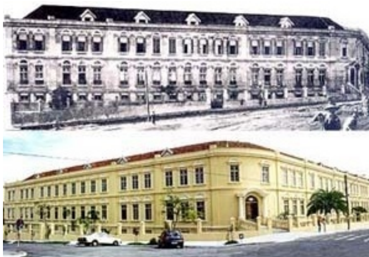
Imagem 15: Prédio Escola Feminina Artes e Ofícios de Santa Maria.
