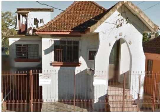
Figura 11 - Casa da Angelita na Rua Marechal Deodoro
