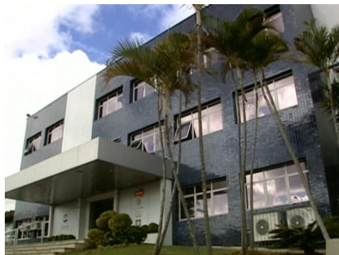
Figura 8: Imagem externa do prédio da RBS TV
