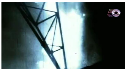
Figura 56: Imagem do incêndio na TV Gaúcha
