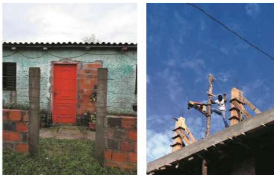
Figura 4 Casas de alvenaria e a construção de edifícios na comunidade
