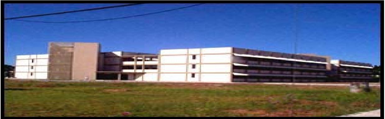
Vista Frontal do Prédio do Centro de Educação- UFSM. Fonte: site hp UFSM Equipe Design/WWW - 2001
