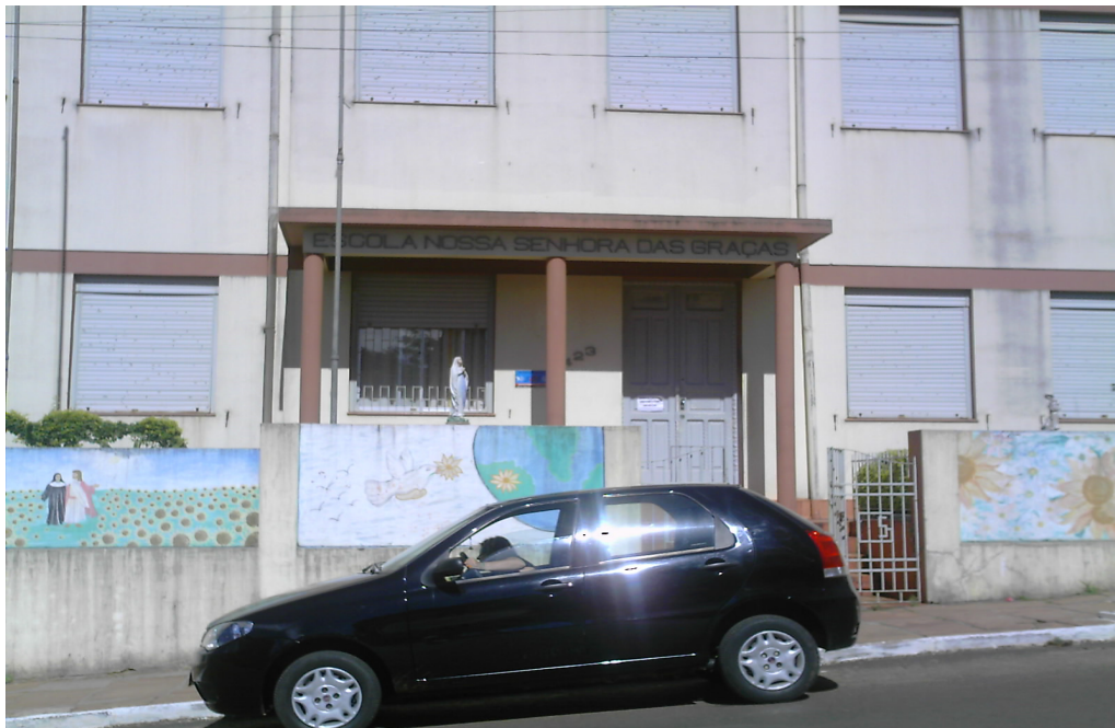
Figura 03 – Pintura no muro – 2009
