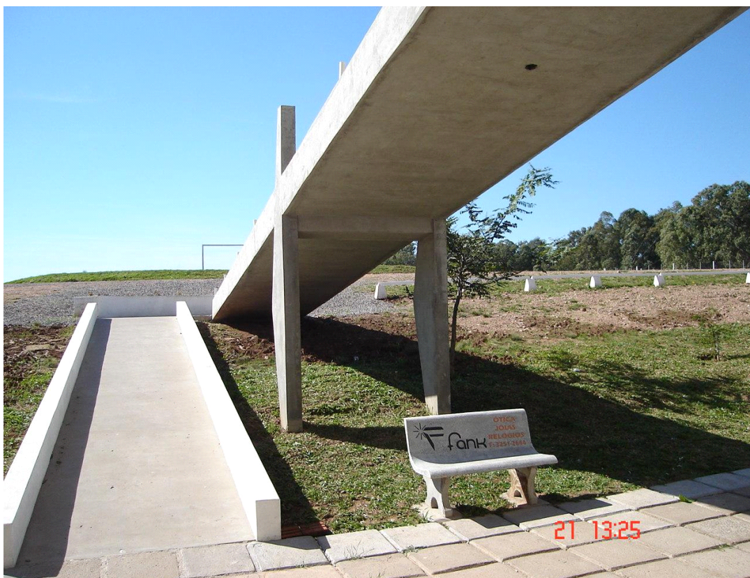
Foto 3 – Rampa de acesso prédio 9.
