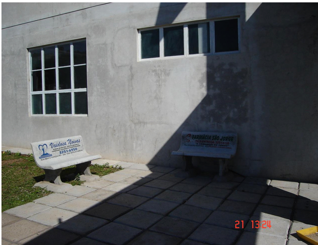
Foto 2 - Estrutura física: nova tomada do prédio 9.
