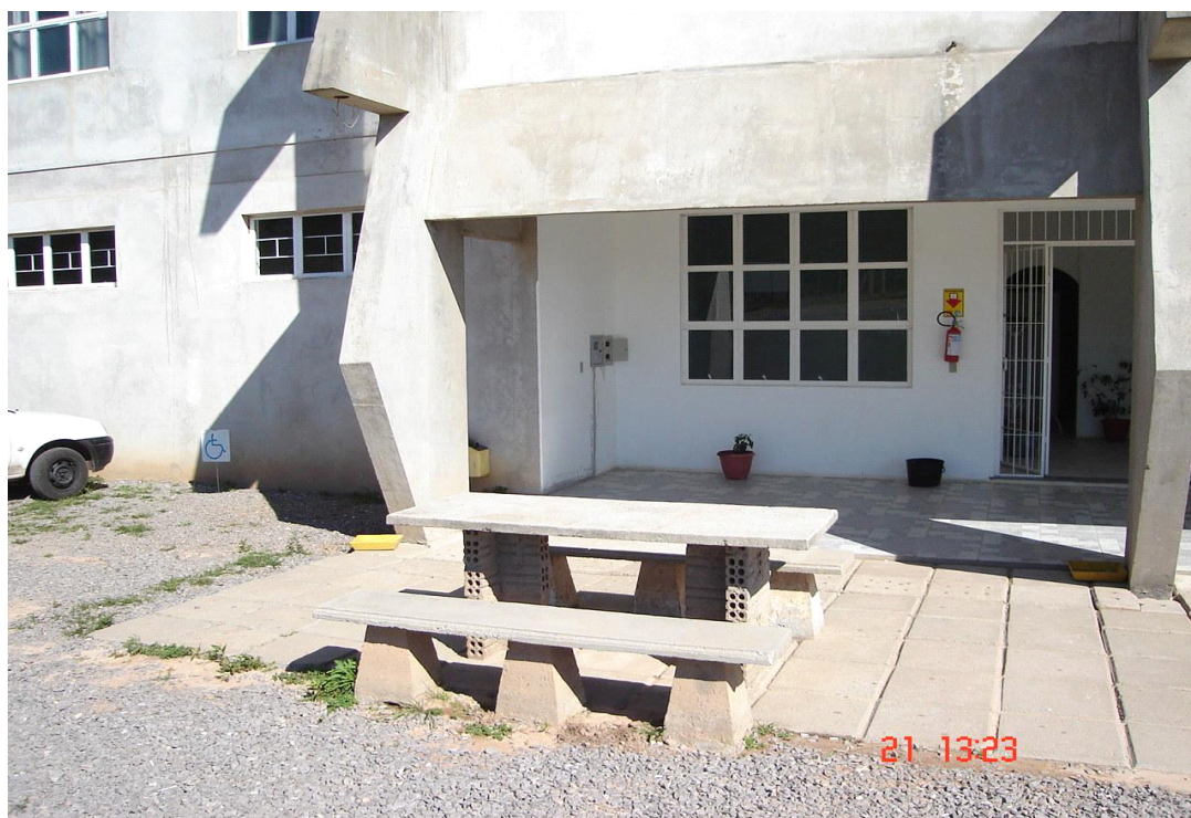
Foto 1 – Estrutura física do prédio 9.
