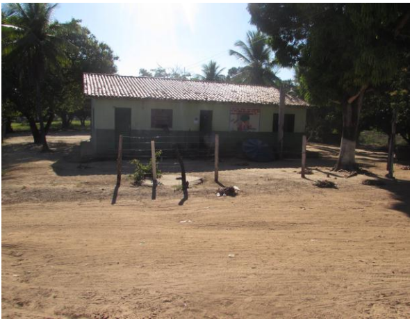
Figura 1: Escola Municipal Maringá
