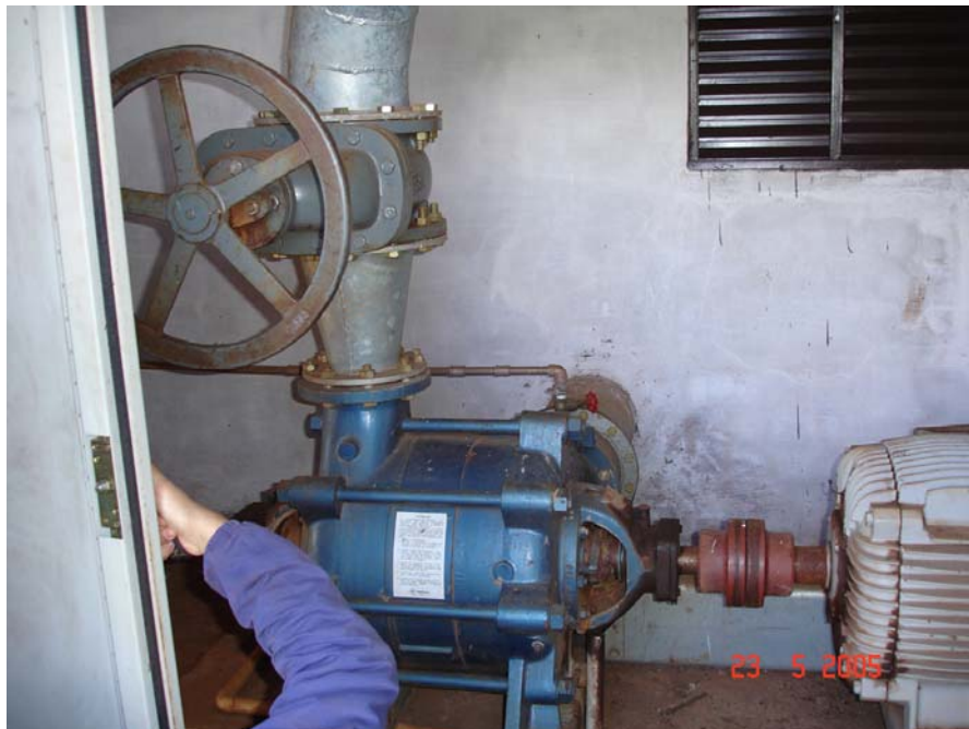
Figura 3 – Conjunto motobomba de um sistema de irrigação por pivô central
