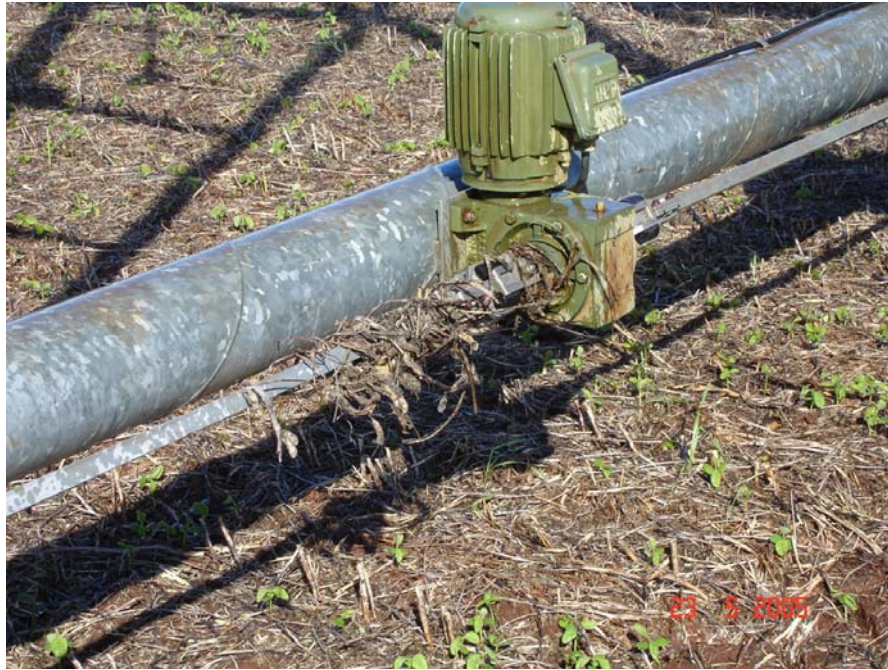
Figura 2 – Conjunto motoredutor e cardans de um sistema de irrigação por pivô central
