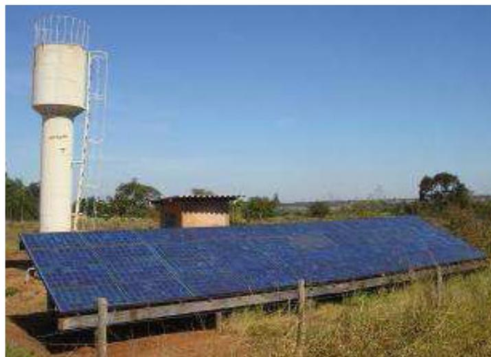
Figura 9 – Sistema de bombeamento fotovoltaico com caixa de água elevada.
