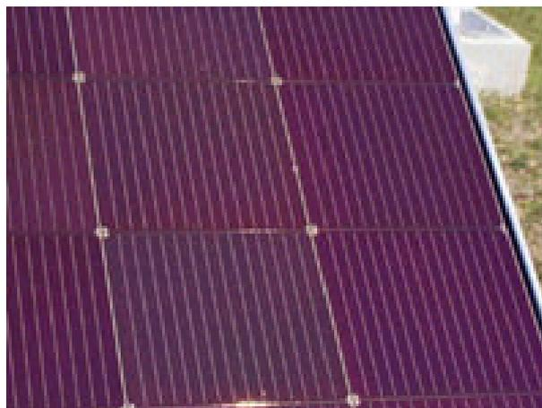
Figura 5 – Painel com célula de silício amorfo.
