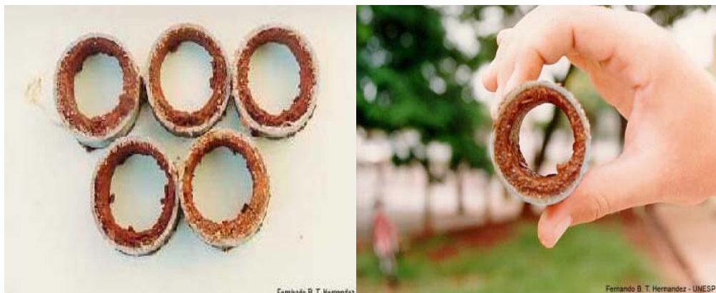
Figura 1 - Incrustações por ferro em tubulações.
