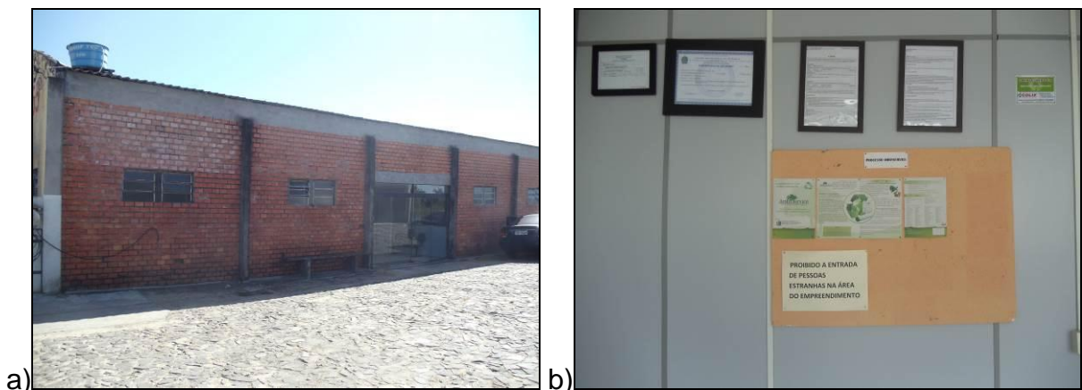
Figura 30 – Imagens da empresa B a) Fachada; b) Hall de entrada
