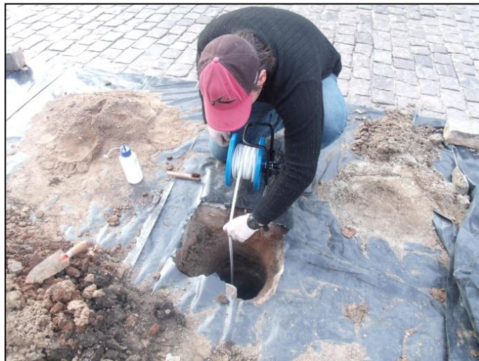
Figura 13 – Medição do nível estático nas ST 02, após estabilização do nível freático
