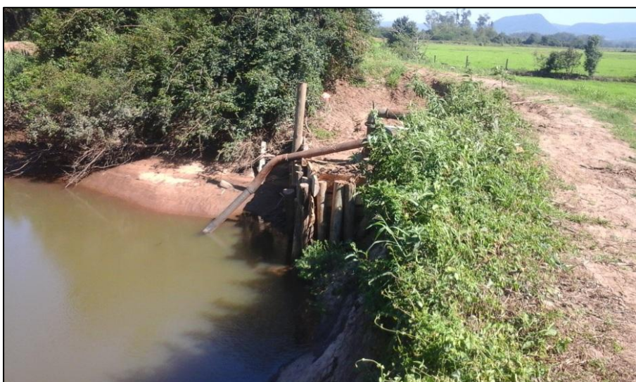
Figura 24 - Captação de água para irrigação de lavouras de arroz
