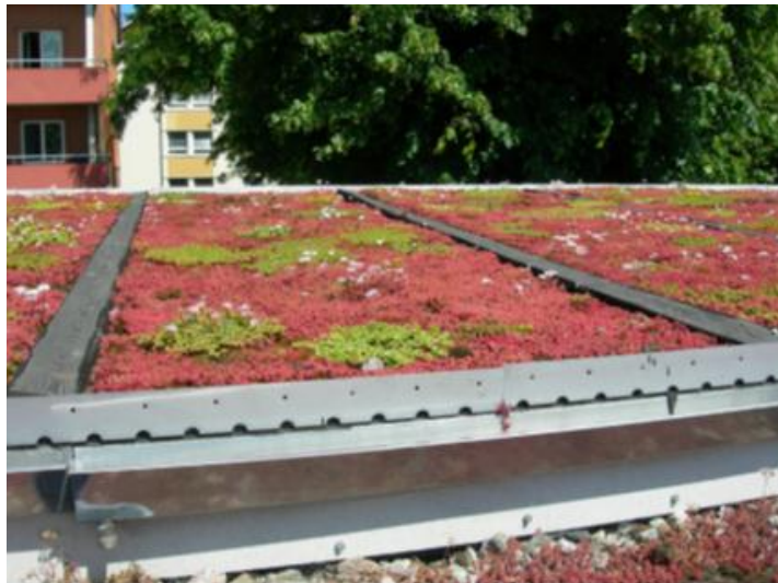
Figura 2 – Telhado verde extensivo em Malmö, Suécia
