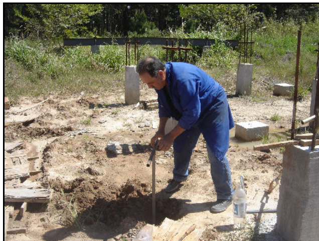
Figura 3. 12 – Sondagem a trado ST-1, localizada na área de estudo
