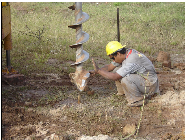
Figura 3. 2 – Escavação das estacas de reação
