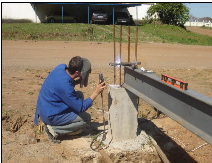
Figura 3. 6 – Soldagem e nivelamento das vigas de reação
