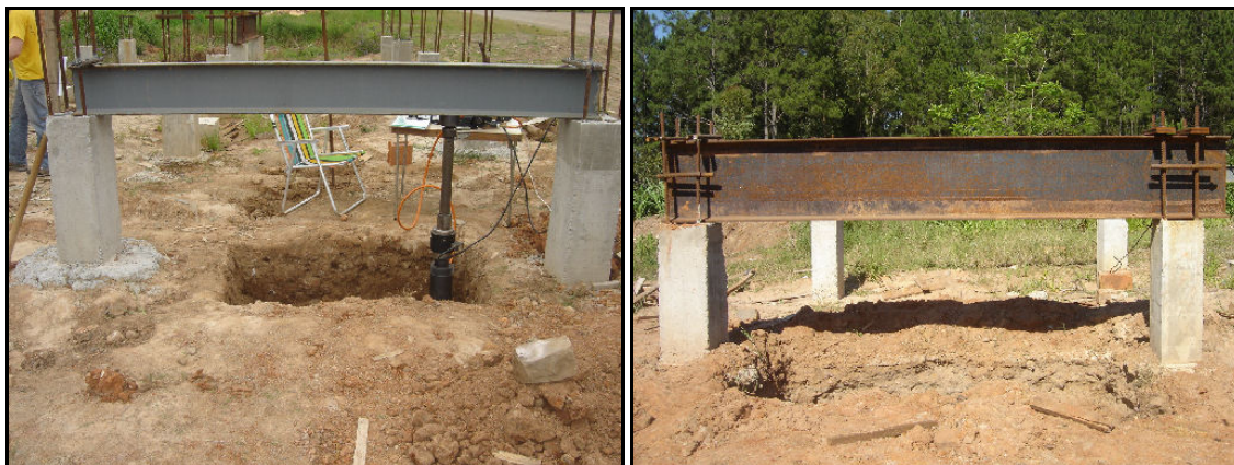
Figura 3. 5 – Vigas de reação
