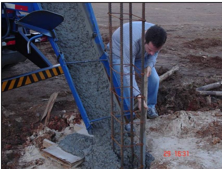
Figura 3.4 – Concretagem das estacas de reação
