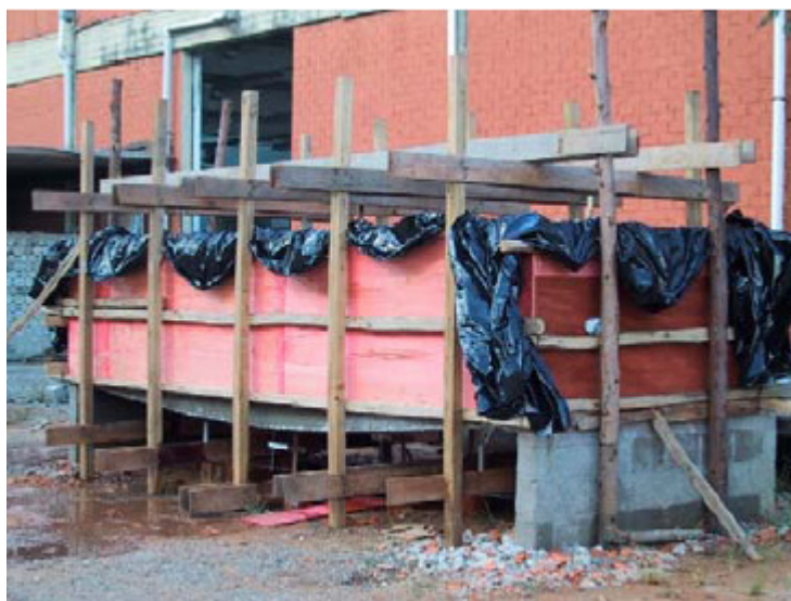
Figura 2.18 – Laje próxima da ruptura, nos ensaios de SILVA FILHO (2002).
