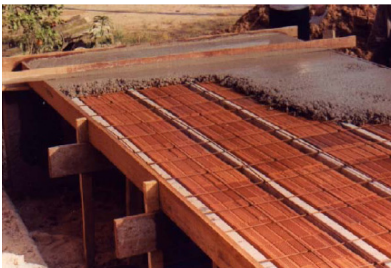
Figura 2.17 – Concretagem da capa de concreto da laje de SILVA FILHO (2002).
