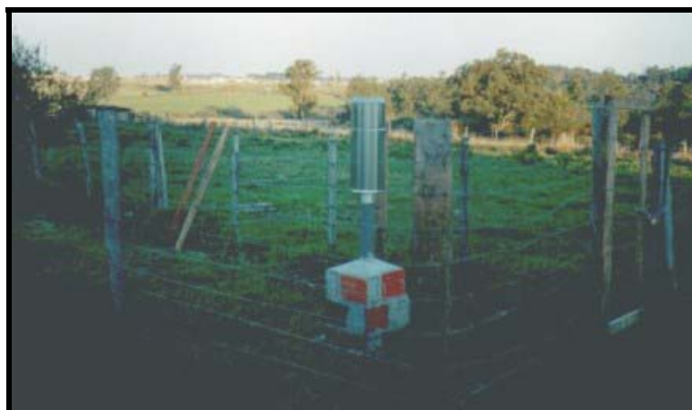
FIGURA 15. Estação pluviográfica Vila Maria
