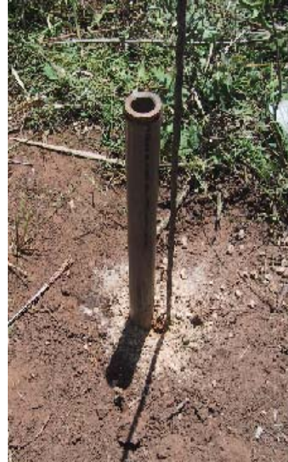
Figura 3.6 – Montagem do piezômetro
